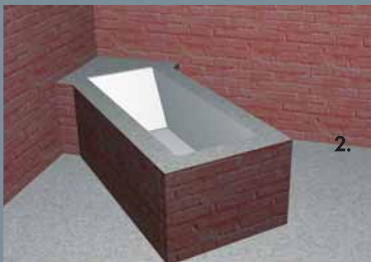
Obezdit cihlou (nezapomeňte na montážní otvor k odpadu)
