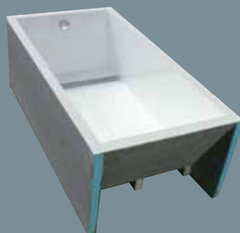
Obezdit cihlou (nezapomeňte na montážní otvor k odpadu)
